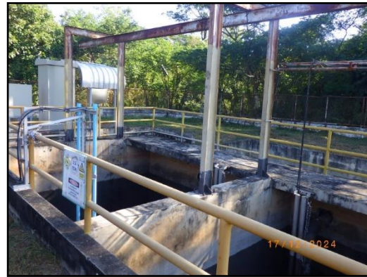
บริเวณบ่อน้ำเสียก่อนเข้าสู่ระบบ (Pump Sump)
